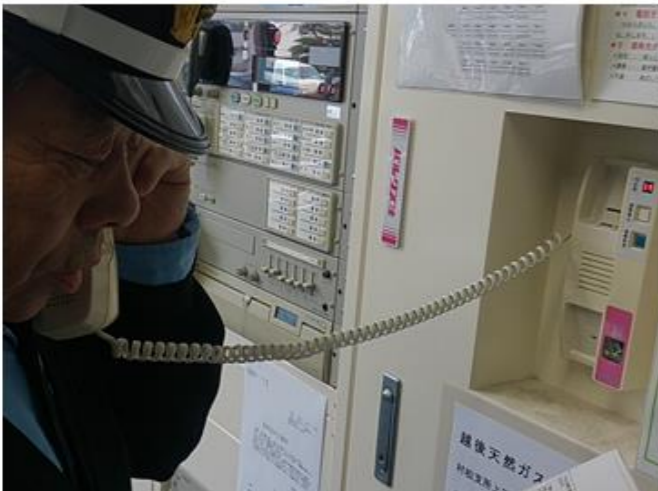
③ 現地確認後・消防署への通報 (通報訓練)
